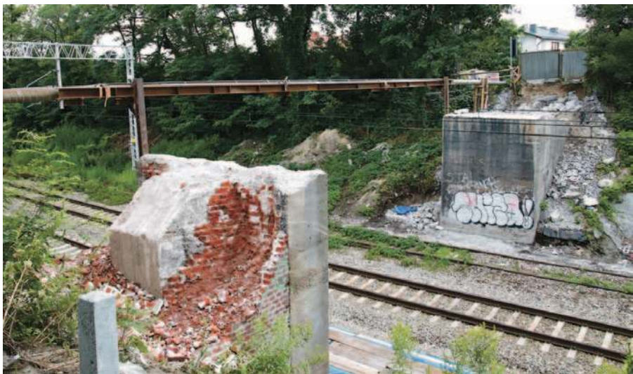
Choć może jeszcze tego nie widać, ten wiadukt na ul. Traugutta powstanie do końca bieżącego roku
