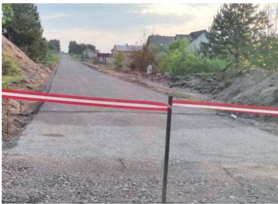
Trwa budowa drugiej linii zabudowy w Hedwiżynie (foto: maj 2023). Planowy koszt inwestycji oszacowano na kwotę ok. 5,6 miliona złotych
