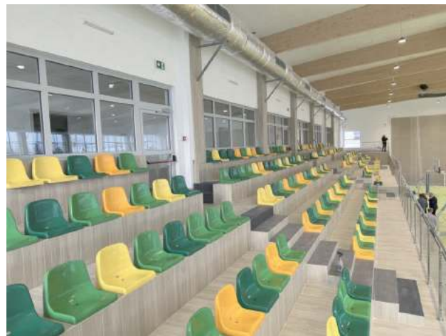
Obiekt z pełnowymiarową areną sportową i trybuną stałą na 300 osób
