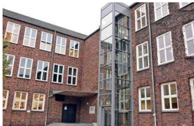
W „Ogólniaku” wybudowano windę (fot. powiat nowosolski)
