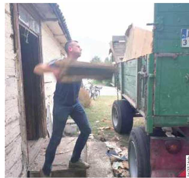
- Właściwie wszyscy mieszkańcy się zaangażowali, także pracownicy firm budowlanych, którzy pracują pod kierunkiem pana Wiesława Tryczyńskiego - mówi wójt Grochowski
