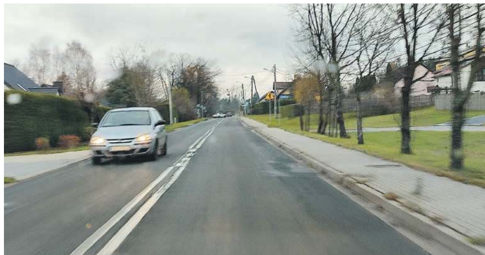
Ul. Styczniowa w Luszowicach to jedna z dróg powiatowych, która zostanie wyremontowana
