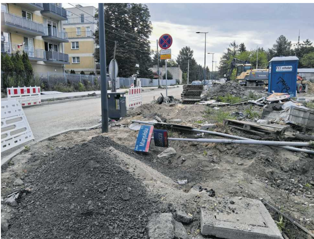
• Remont ulicy Marysińskiej
