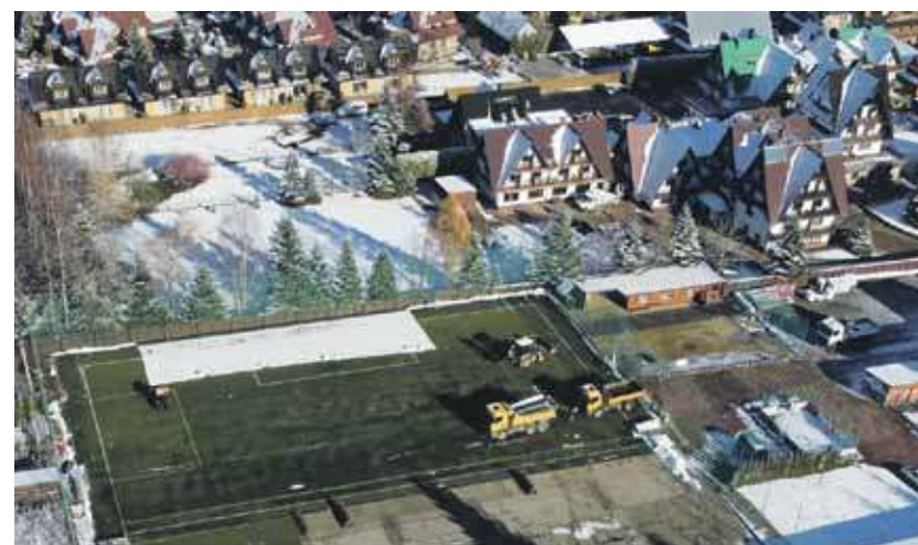
Trwa rozbiórka boiska na Pardałówce w Zakopanem.
