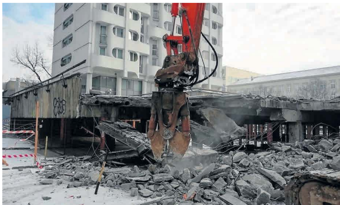
Rozebrana zostanie część deptaku od wewnętrznej strony, w kwadracie oddzielonym ulicami Nauczycielską i Polaka
