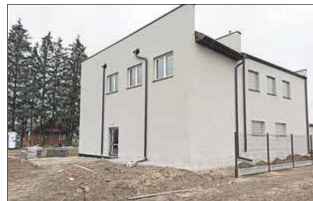
W budynku po byłej Spółdzielni Kółek Rolniczych będzie funkcjonować spółdzielnia socjalna. Prace adaptacyjne mają się ku końcowi
