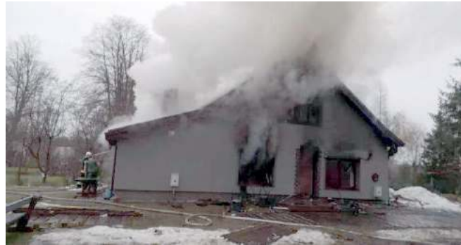
Dom został zniszczony. Nadzór budowlany zdecydował o jego rozbiórce
