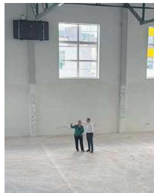
W ramach Rządowego Funduszu Polski Ład remontowana jest hala sportowa i jej zaplecze
