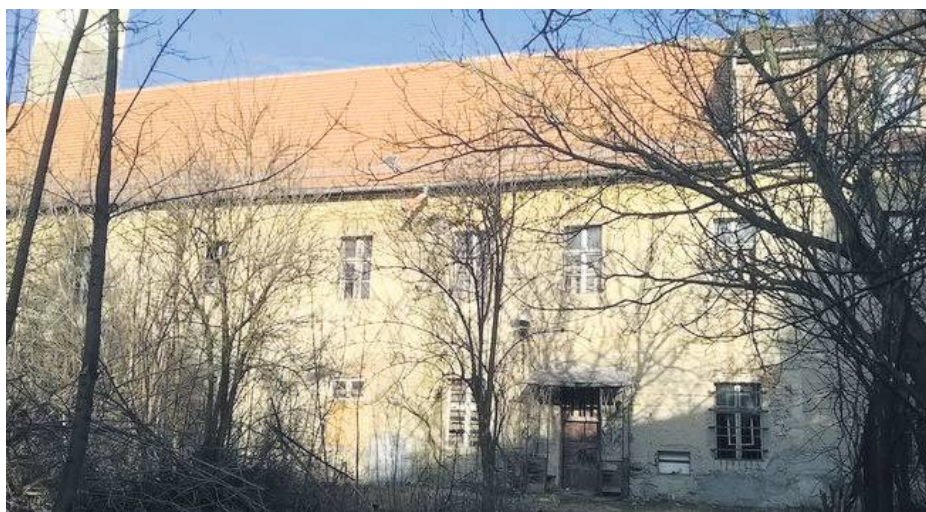
Do Rządowego Programu Odbudowy Zabytków złożono wniosek na remont dachu oraz refektarza zabytkowego Klasztoru Sióstr Boromeuszek w Strzelinie. Foto: archiwum Słowa
