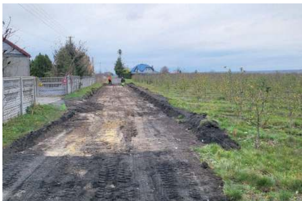
Wykonawca rozpoczął prace od wybrania ziemi i uformowania koryta drogi, w którym wykonana zostanie podbudowa
