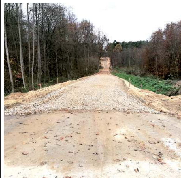
Nowa droga powstaje w kompleksie leśnym. Stanowić ma dojazd pożarowy
