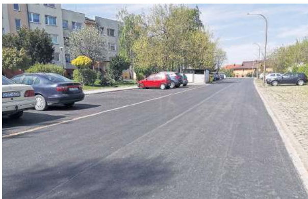
Nawierzchnię wyremontowano od ulicy Okulickiego do skrzyżowania z ulicą Krzywoustego (Foto. UMiG Strzelin)
