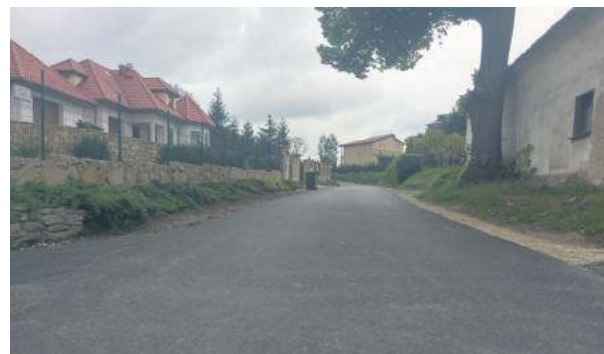
Wykonawca remontu ul. Dębowej w Gęsińcu zakończył prace ponad miesiąc przed terminem
