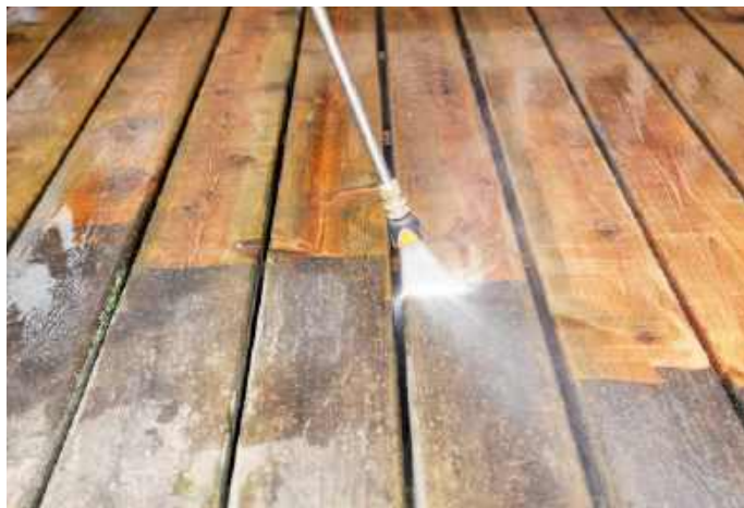
🔧 Drewniany taras trzeba co sezon umyć (najlepiej myjką ciśnieniową) i ponownie zabezpieczyć przed działaniem czynników atmosferycznych.
