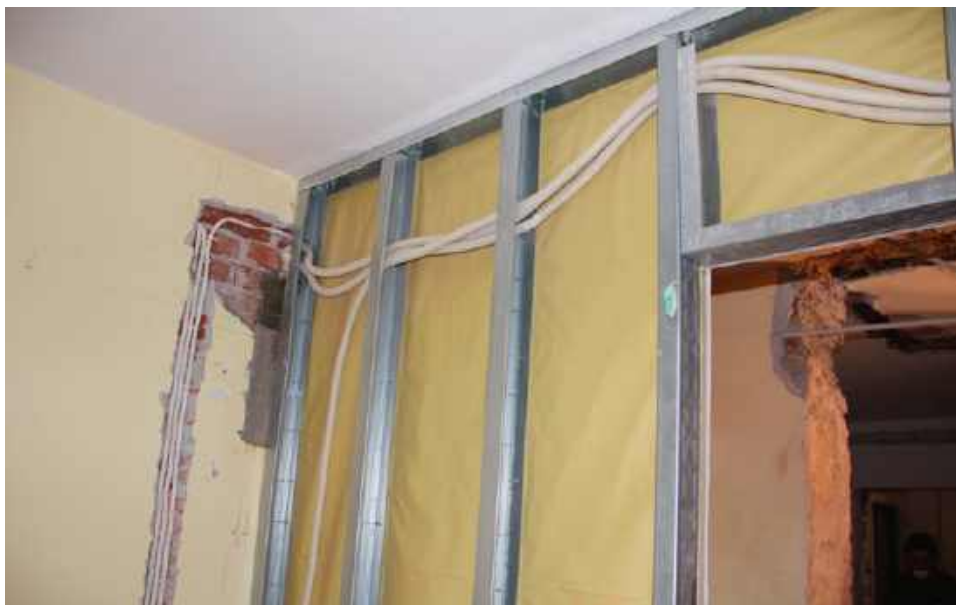
🔧 Do ukrycia przewodów tworzących nowe obwody elektryczne można z powodzeniem wykorzystać np. wnętrze ścianek szkieletowych. J. WERNER
