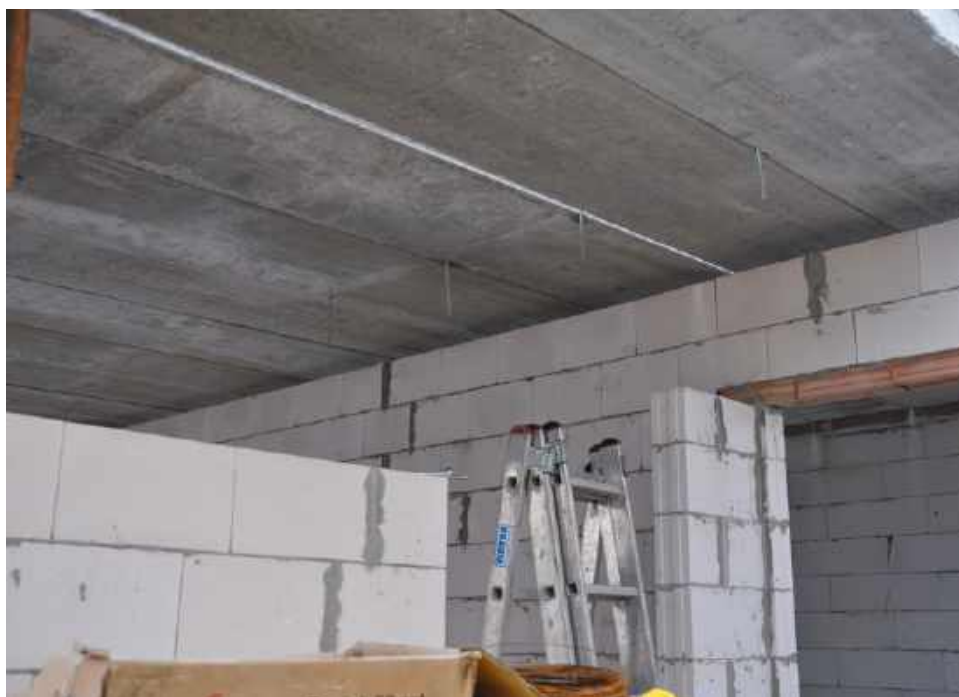
🔴 Stropy prefabrykowane po zamontowaniu tworzą idealnie równy sufit. W niektórych z nich można ukryć instalacje. STROPY.PL
