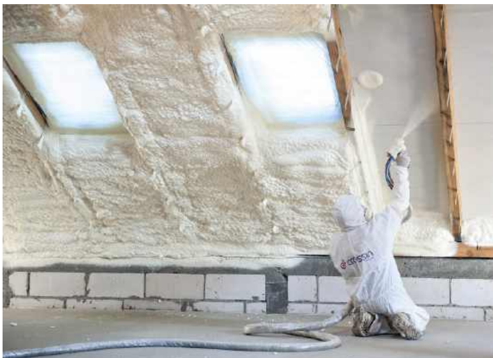
🔧 Typowe poddasze pianą PUR można ocieplić w jeden dzień. PCC PRODEX
