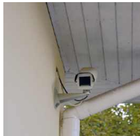
Kamery na ogół mają szerokie pole widzenia i siłownik do jej obracania. L. JAMPOLSKA
