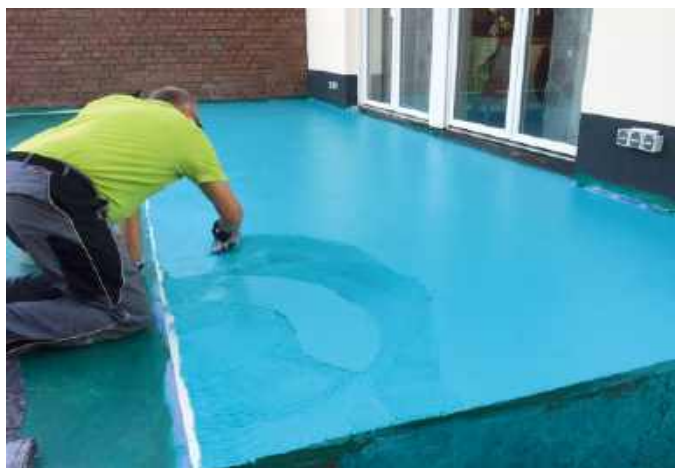
🔧 Przy remoncie tarasu, na którym planowane jest ułożenie płytek, bardzo ważne jest wykonanie trwałej izolacji przeciwwilgociowej. BOTAMENT
