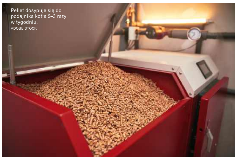
● Pellet to paliwo w postaci granulatu, uzyskiwane z biomasy, np. odpadów drzewnych. ARCHIWUM BD
