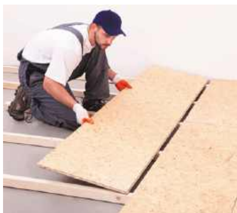
🔧 Podkład pod posadzkę można wykonać z płyt drewnopochodnych. KRONOPOL
