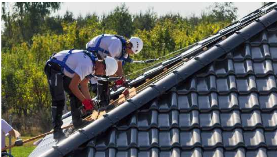
🔧 Zakres prac wykonanych na dachu powinien ocenić specjalista. Remont to nie tylko montaż nowego pokrycia, ale bardzo często wymiana izolacji i wzmocnienie więźby. CREATON POLSKA
