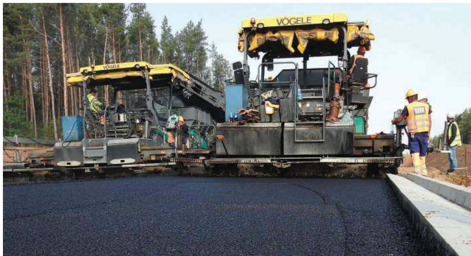
Ekipy drogowców kładą asfalt przy wjeździe od strony Olsztyna
