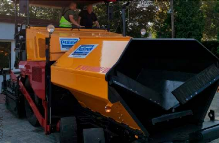
Dzięki zastosowaniu nowej metody z wykorzystaniem rozścielacza do kładzenia asfaltu i kruszywa drogowego (na zdjęciu), który Pegimek kupił w ubiegłym roku oraz recyklera świdnickie gruntówki naprawiane są nie tylko szybciej i solidniej, ale również o wiele tańszym kosztem
