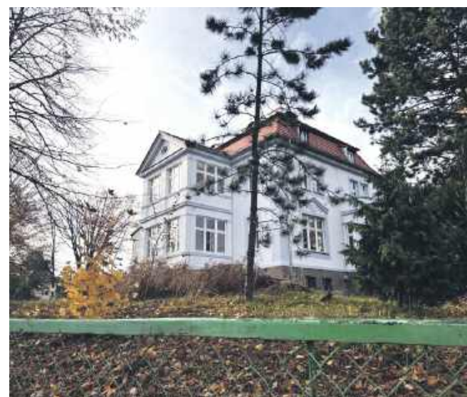
Część elewacji czwartej ściany już odnowiono
