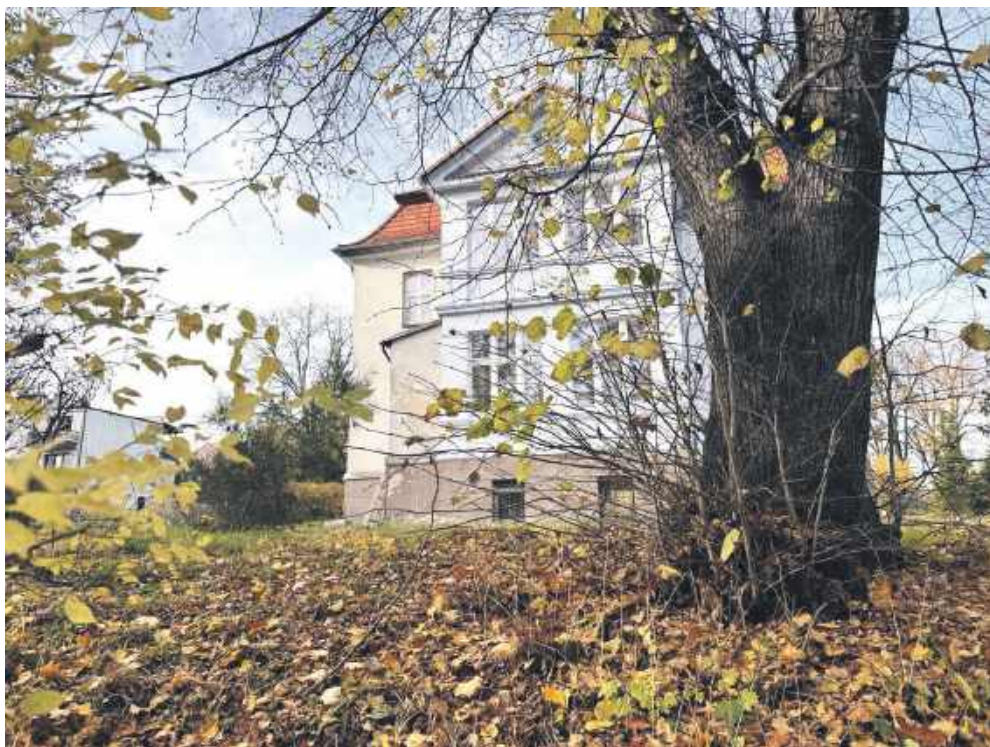
Tu widać, że fragment elewacji jest jeszcze stary
