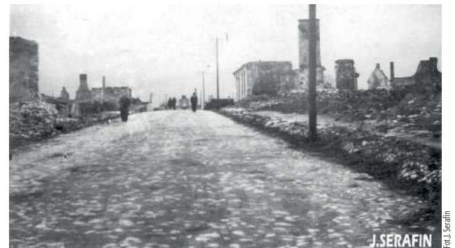
Ulica Lubelska w kierunku Rynku. 8 września 1939 r. lotnictwo niemieckie bombarduje Biłgoraj, a 11 września dywersanci niemieccy podpalają miasto w kilkunastu punktach. Spłonęło 1006 budynków, cały rynek i przyległe ulice. Zniszczono 70 procent miasta
