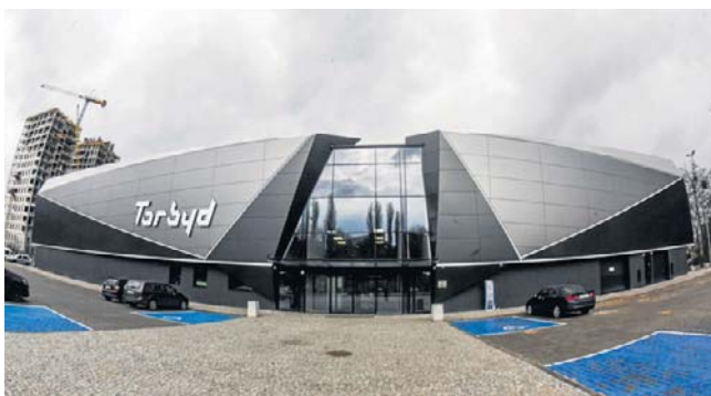
Na „Torbydzie” zostanie zamontowanych 335 modułów
