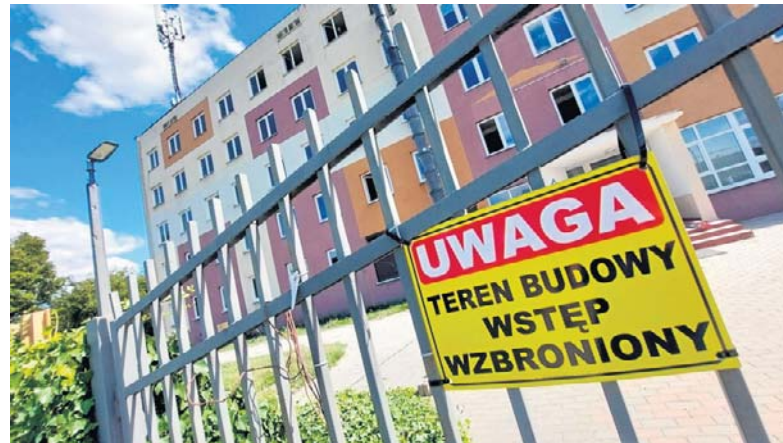
Remont internatu szkolnego przy ulicy Mechaników ma potrwać jeszcze niecały rok
