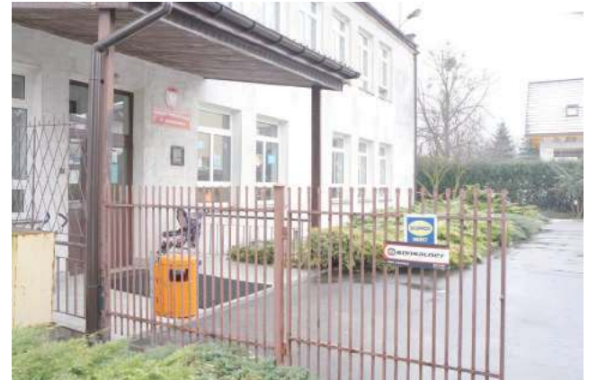
Jednym z budynków, który w pierwszej kolejności ma przejść termomodernizację jest przedszkole w Końskowoli
