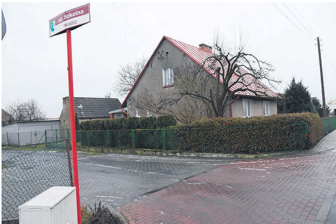
Ulica Szkolna w Pruszczy. Ma być przebudowana.
