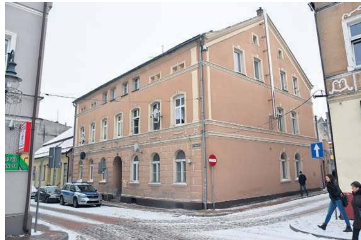
Pożar miał miejsce w kamienicy przy ul. Sępoleńskiej 2 w nocy z 3 na 4 stycznia. Z boku widać nowy komin wyprowadzony z jednej części mieszkania (w październiku 2018 roku). W drugiej części pojawił zabójczy ogień i dym. Fot. (kt)
