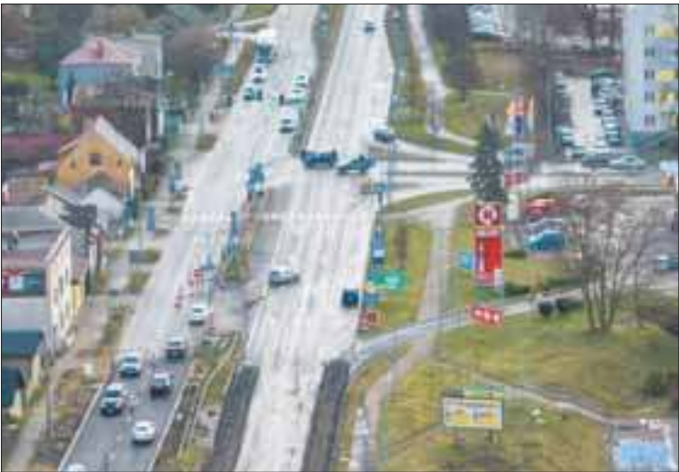
Zakończenie całości prac na odcinku planowane jest na koniec czerwca 2023 roku
