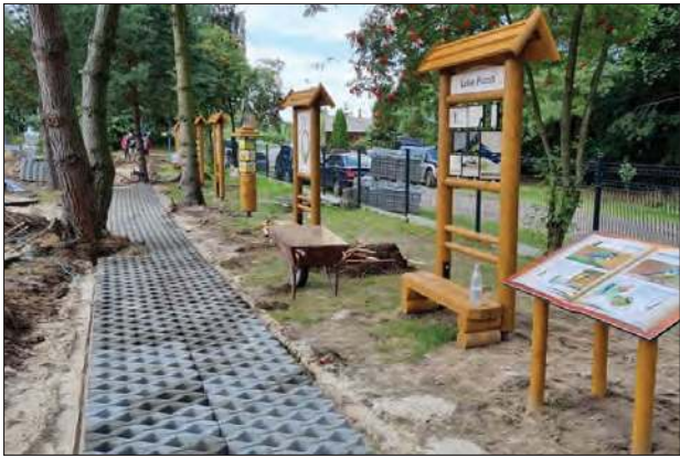
Zakończono budowę ścieżki edukacyjnej. Trwają jeszcze prace przy zagospodarowaniu terenu
