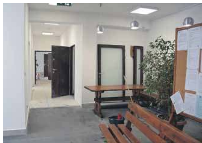
Budynek gminy w Szaflarach w trakcie remontu.
