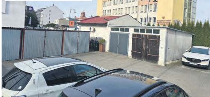
W miejscu garaży przy ul. Pocztowej ma zostać wybudowany dwukondygnacyjny obiekt. Znajdą się w nim miejsca schronienia i przetrwania oraz magazyn.
