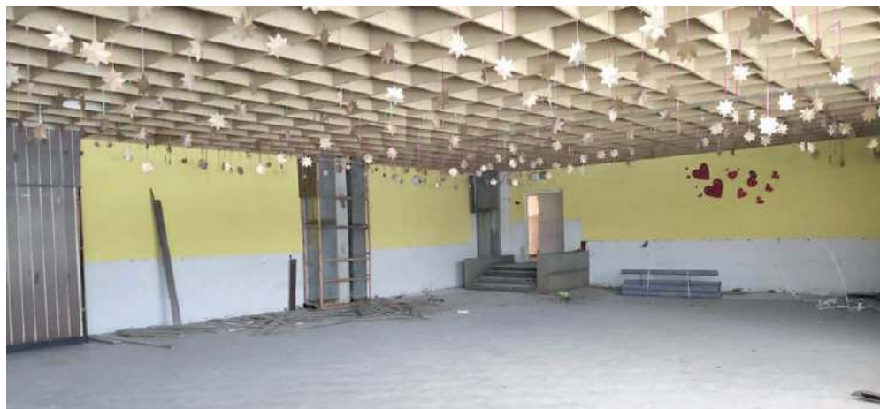
Na „pierwszy ogień” poszły prace rozbiórkowe
