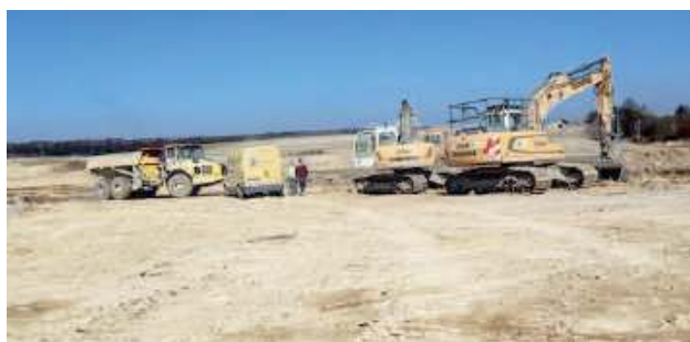
Obecnie prowadzone są roboty rozbiórkowe i ziemne
