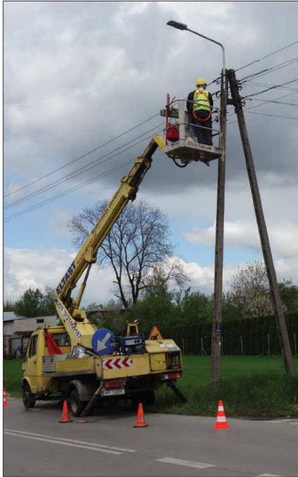
➤ Modernizacja oświetlenia ulicznego i parkowego potrwa do końca września. Zakłada wymianę lamp na energooszczędne oraz budowę 15 słupów przy ul. Balonnej
