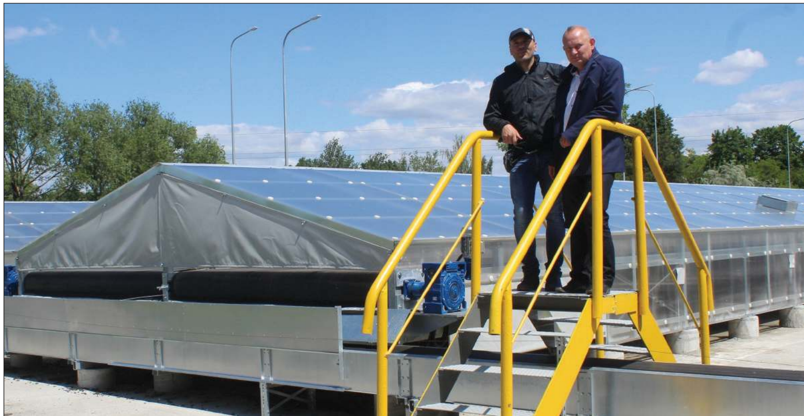
■ Cztery potężne suszarnie o długości kilkudziesięciu metrów są w fazie rozruchu. Na zdj. Piotr Bartoszewski (z lewej), prezes firmy Arto sp. z o.o. oraz Artur Czerski, kierownik zakładu wodociągów i kanalizacji
