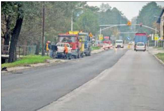
Drogowcy rozpoczęli prace 22 października
