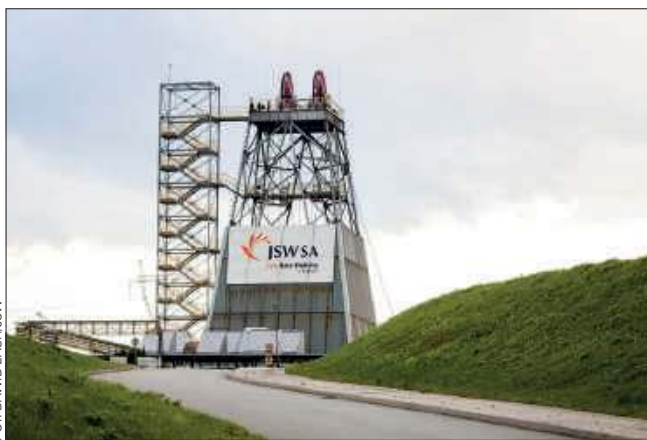
Kopalnia Jastrzębie-Bzie ma ruszyć z pierwszą ścianą w grudniu 2021 roku
