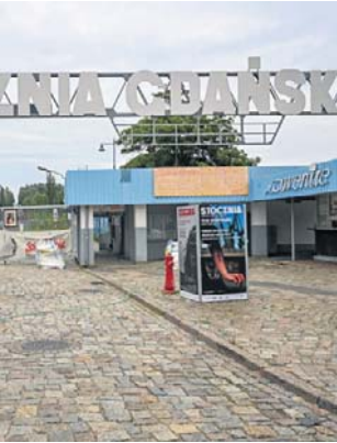
18 CZERWCA, GDAŃSK. Trwa remont dawnej portierni przy Bramie nr 2
