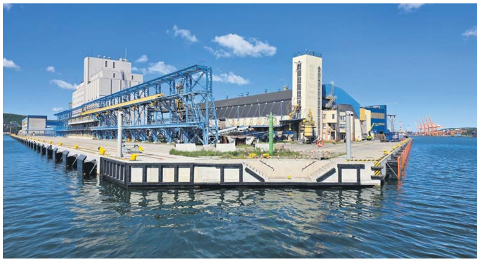
ZMPG S.A./ Nabrzeże Indyjskie po przebudowie
