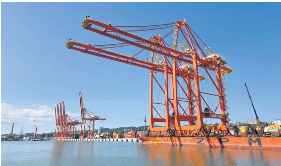
ZMPG S.A./ Nabrzeże Helskie po przebudowie
