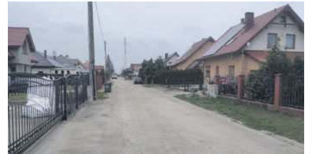
Czy ul. Wrzosowa w Borowie doczeka się pięciometrowej nawierzchni asfaltobetonowej i chodników?
