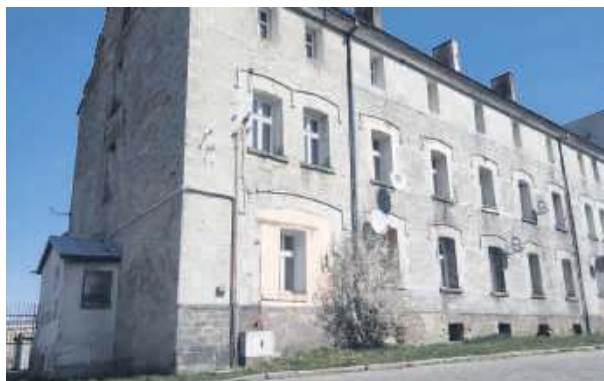
Poznając gminę Strzelin, można by zwiedzić dawne więzienie, a dziś budynek mieszkalny
