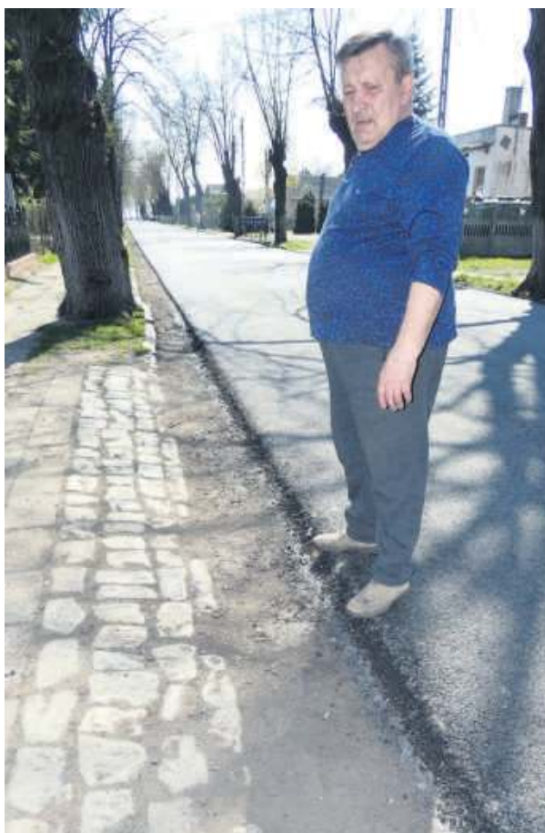
Mieszkaniec Starego Wiązowa zwrócił uwagę, że nawierzchnia asfaltu jest zbyt wysoko w stosunku do pasa przy jezdni, przez co wyjazd z posesji jest utrudniony i grozi uszkodzeniem samochodu
