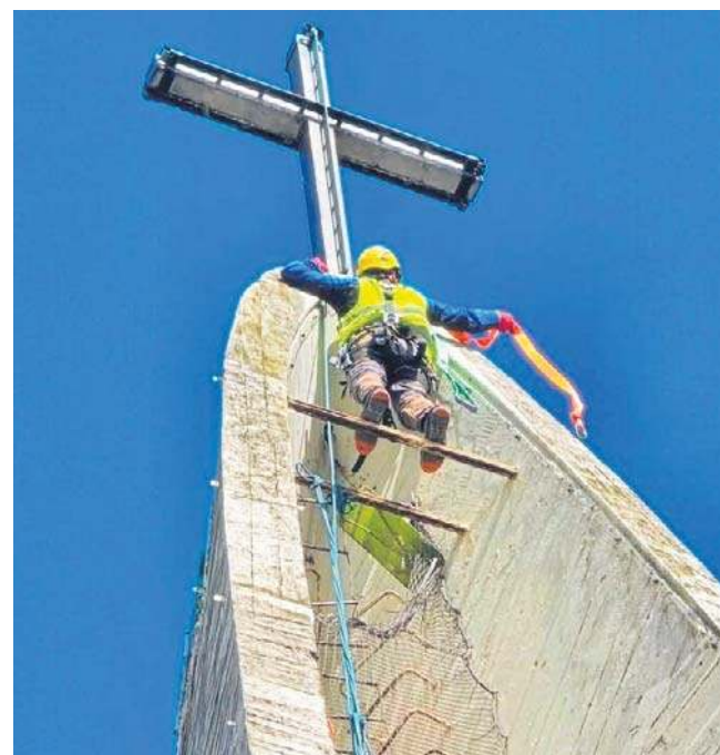
Obiekt remontują... alpiniści.
