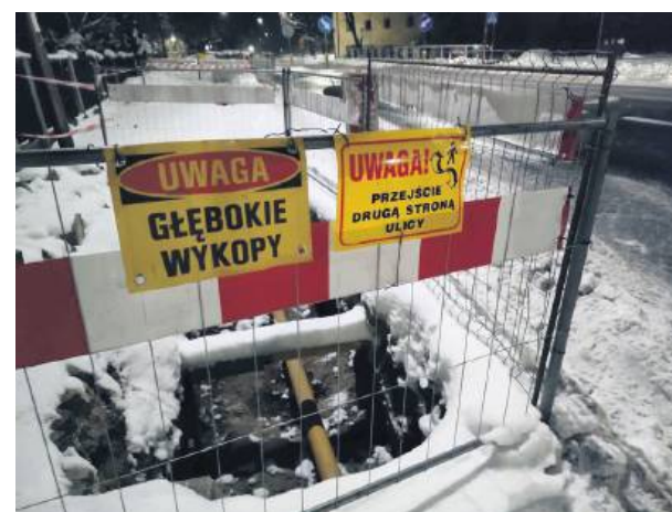
Wykopy związane z usuwaniem awarii gazowej sieci
