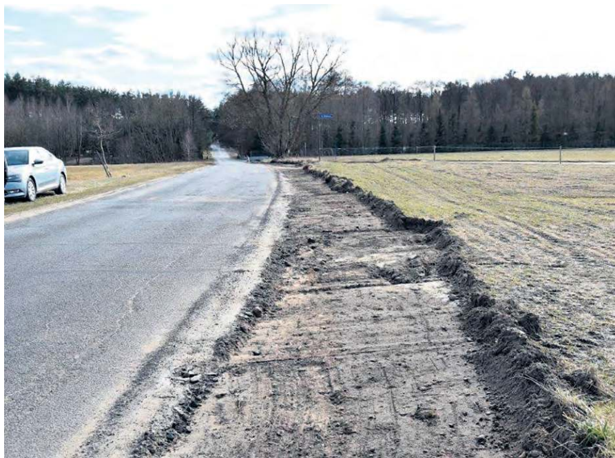
Zdjęcie wykonano na początku remontu drogi ze Śliwic w kierunku Czerska. Prace systematycznie się posuwają. Ich zakres przedstawiamy w artykule.
