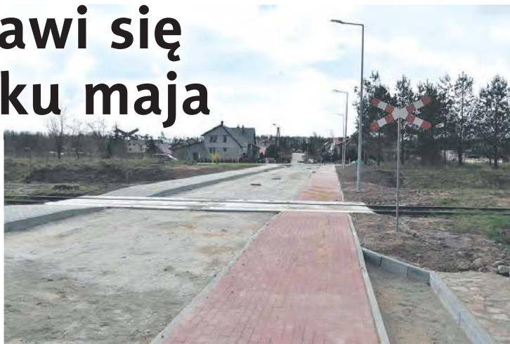
Ulica Szkolna przygotowana do zalania asfaltem.
