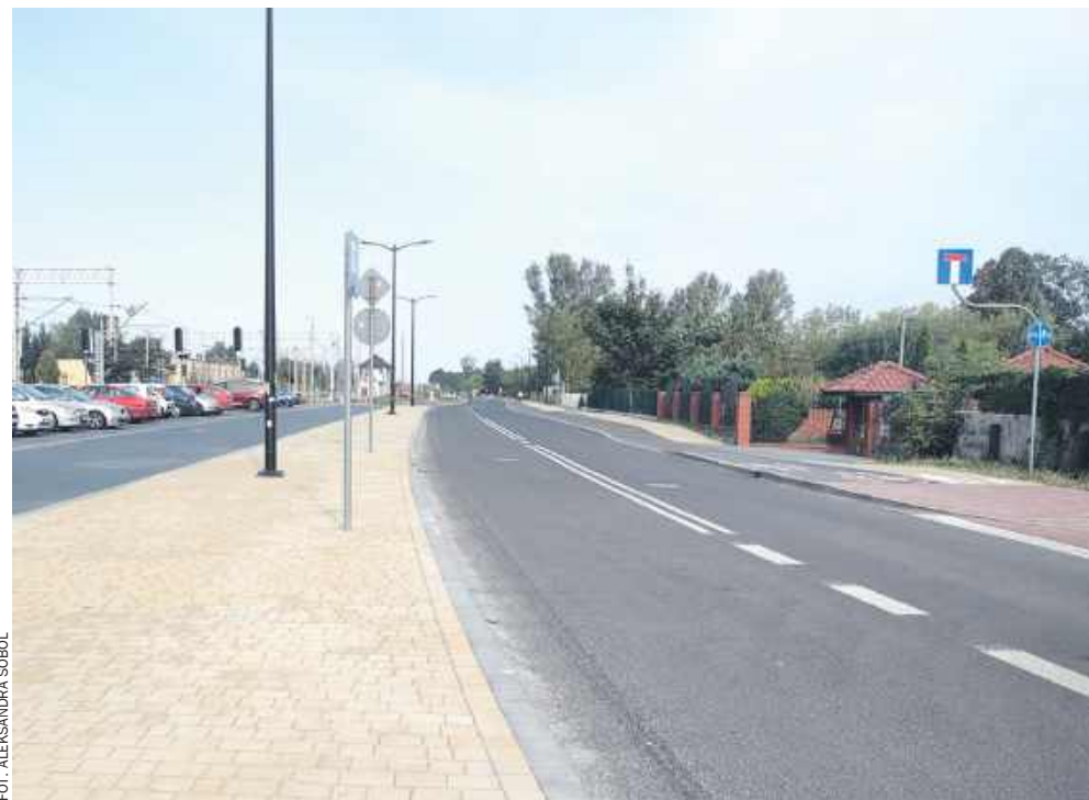
Odcinek ulicy Dąbrowskiego przebudowany w drugim etapie służy już mieszkańcom
