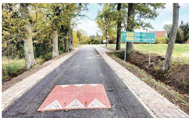
W gminie powstało ponad 12 kilometrów nowych odcinków dróg
