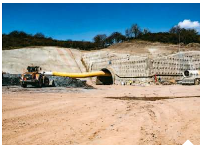
Widok na przecięte budową Góry Wałbrzyskie | fot. Tomasz Hamrat/Gazeta Polska
