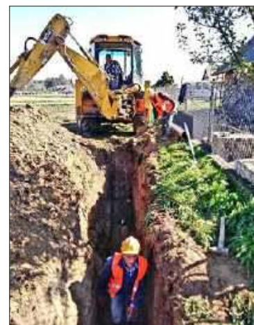
Prace trzeba będzie zakończyć w 2024 roku. fot. ZGDW
