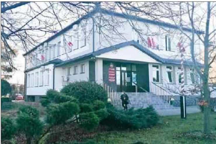
Budynek Urzędu Gminy już po remoncie.
