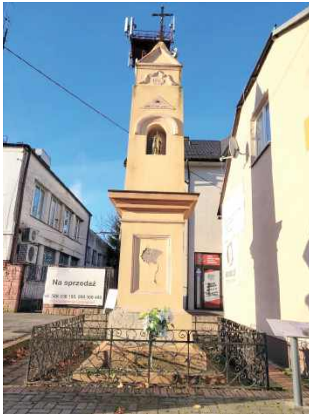
Kapliczka przed remontem
