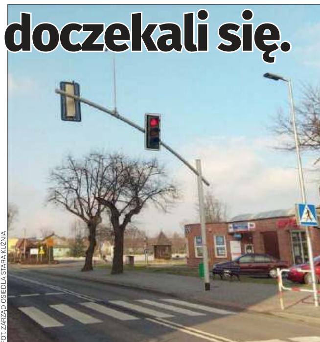
Oto sygnalizacja, która od kilku miesięcy stoi już w Kuźni Raciborskiej. Uruchomiona została 11 stycznia.
