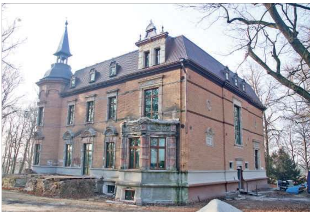
W rzuchowskim pałacu postępują prace renowacyjne. Nie tak dawno obiekt został wyposażony w okna.
