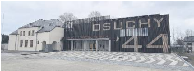
Budowa nowego obiektu kosztowała blisko 13 mln zł.
