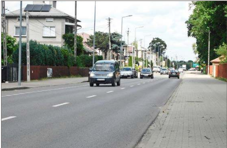
Gładki asfalt i prosty odcinek drogi. To wielu kusi do dodania gazu.
