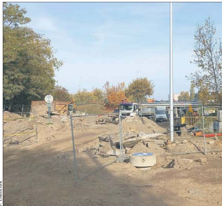
Na ulicy Spółdzielczej prace są prowadzone między innymi pod wiaduktami drogowymi w ciągu al. Piłsudskiego
