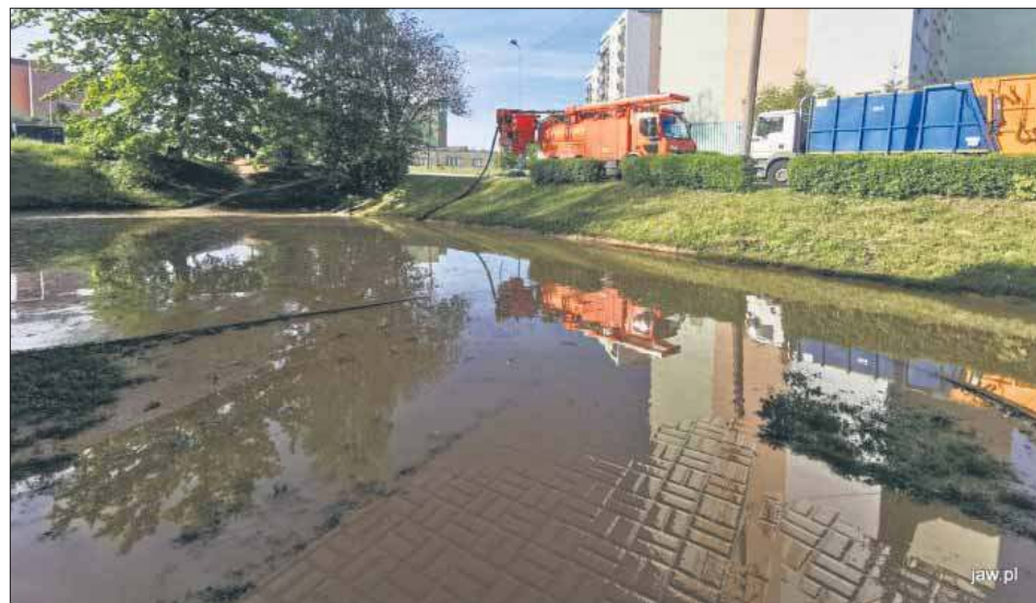
Pracownicy Wodociągów Jaworzno wypompowali wodę z zalanego parkingu
