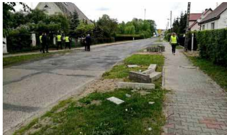
Starosta Stargardzki, przedstawiciele ZDP i firma Strabag ocenili stan techniczny drogi przed rozpoczęciem modernizacji
