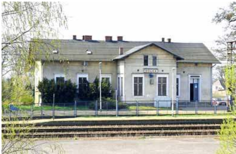
Na odcinku Choszczno – Stargard przebudowana zostanie m.in. stacja kolejowa w Dolicach
