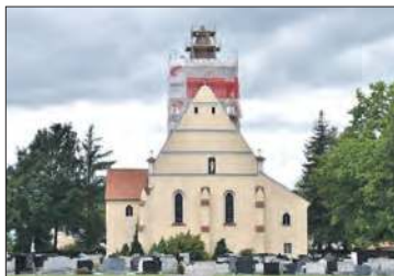
Kościół parafialny pw. św. Anny z rusztowaniami na remontowanej wieży wczesnośredniowiecznej w Niemysłowicach
