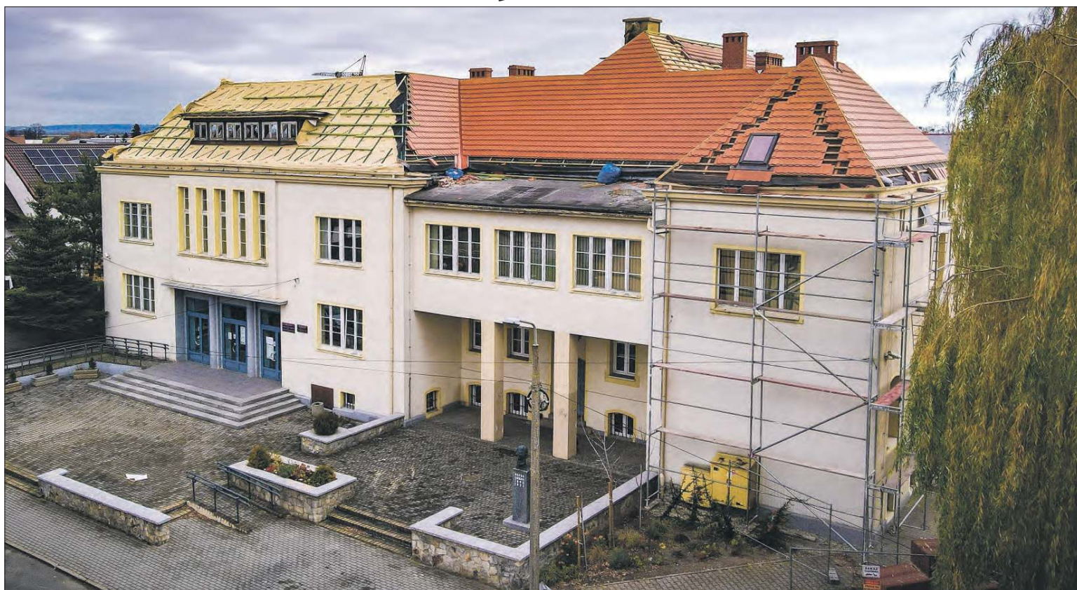
Budynek głogóweckiego domu kultury poddany został modernizacji
