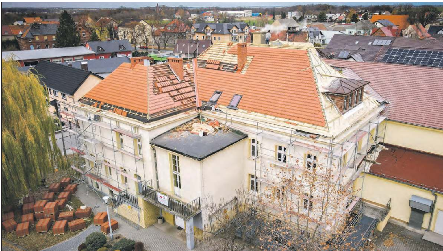
Prace remontowe obejmują zarówno elewację jak i pokrycie dachowe
