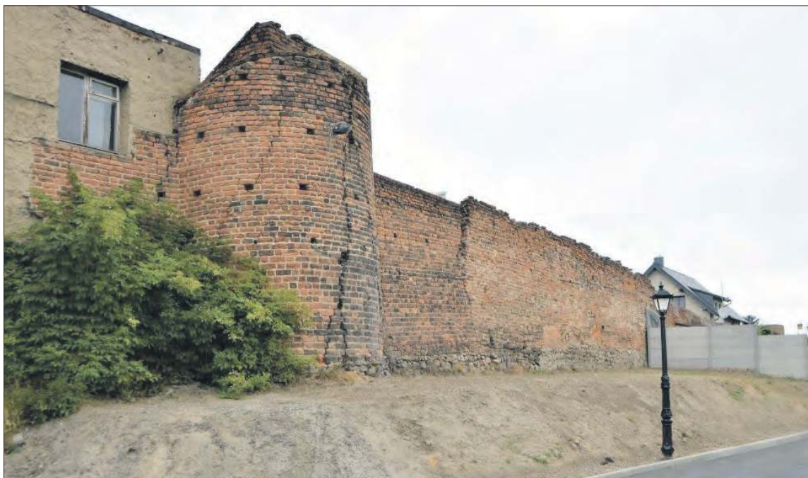
Odremontowany zostanie odcinek murów obronnych
