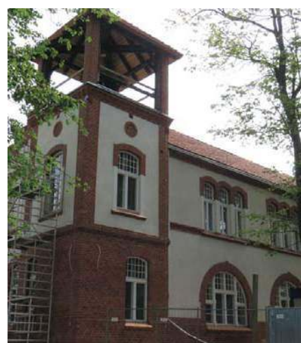
Remont budynku MOK
