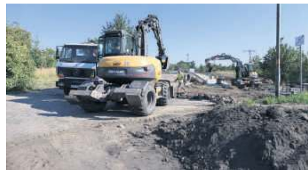
Na budowie pracuje ciężki sprzęt. Nowa ulica będzie biegła po prawej stronie, na wprost miejsca, gdzie stoi koparka (na dalszym planie)
