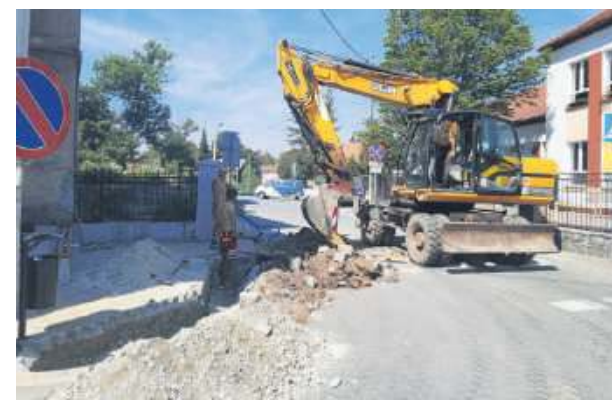
Przy Szkole Podstawowej w Prusach trwa budowa wyniesionego przejścia dla pieszych. Fot. UG Kondratowice
